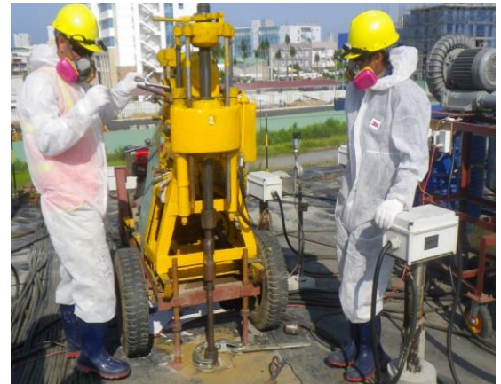
Lấy mẫu xác nhận sau xử lý Giai đoạn 2 trên đỉnh kết cấu xử lý. (Ảnh: CDM Smith)
