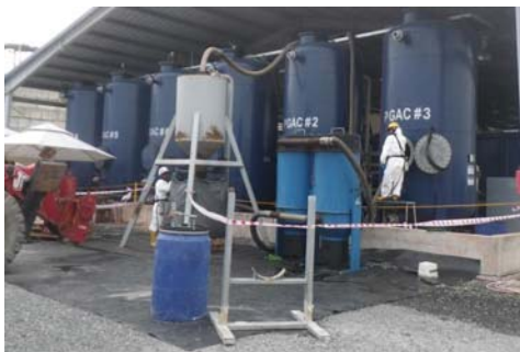
Tháo dỡ than đã sử dụng ra khỏi nhà máy xử lý (Ảnh: CDM Smith)
