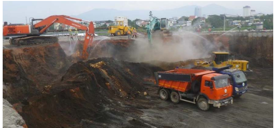
Dỡ đất và bùn đã xử lý trong Giai đoạn 1 khỏi cấu trúc xử lý nhiệt
