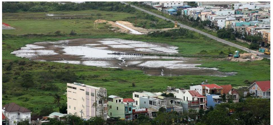
Dewatering Sen Lake
