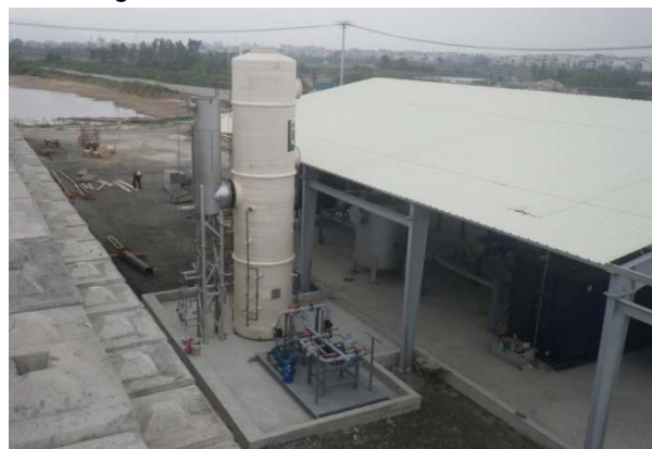
Thi công nhà máy xử lý chất lỏng/hơi
