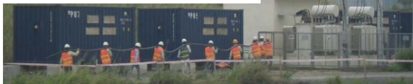
Giăng cáp điện
