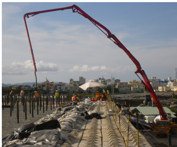
Lắp đặt ống gia nhiệt vào kết cấu xử lý nhiệt (Ảnh: CDM Smith)
