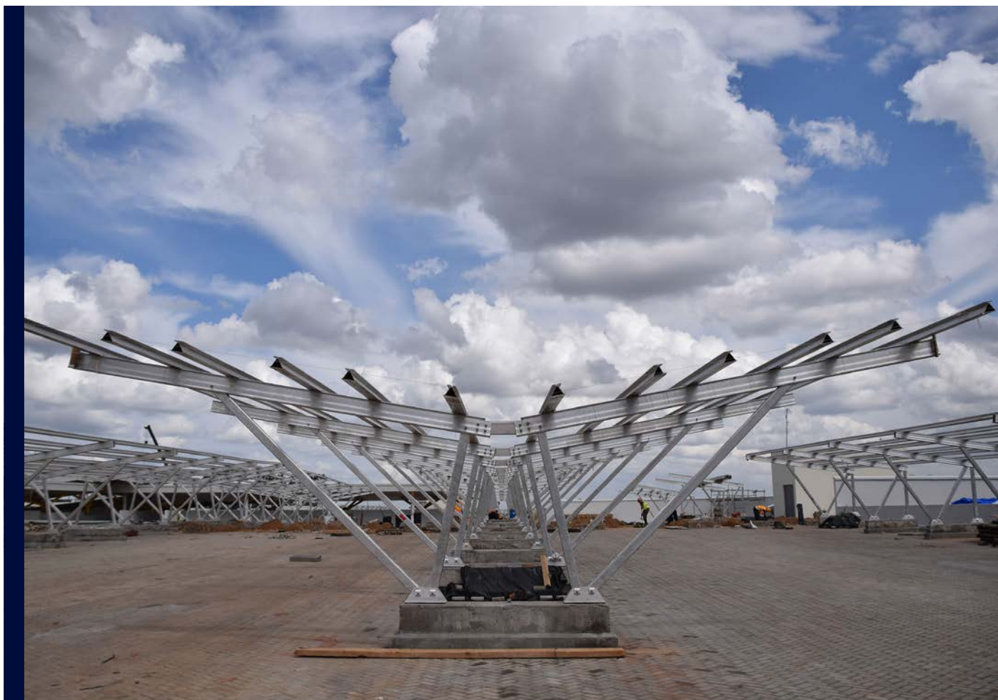
Construction en phases finales de cette installation-auvent d'énergie solaire PV de 858KWp, hautement innovante, au Garden City Mall de Nairobi, au Kenya. Photo : Avec l'aimable autorisation de Cross-Boundary.
