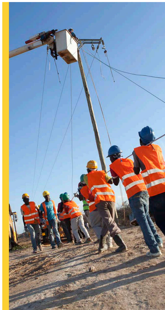
Une équipe d'électriciens de Pike Electric, entrepreneur américain, travaille à la pose de lignes électriques dans la zone rurale de Dodoma, en Tanzanie. Cette initiative fait partie du Projet du secteur énergétique de la Millenium Challenge Corporation. Photo : Jake Lyell pour la Millenium Challenge Corporation.
